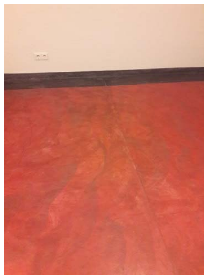
toegepaste cementdekvloer in de Burcht te Amsterdam
